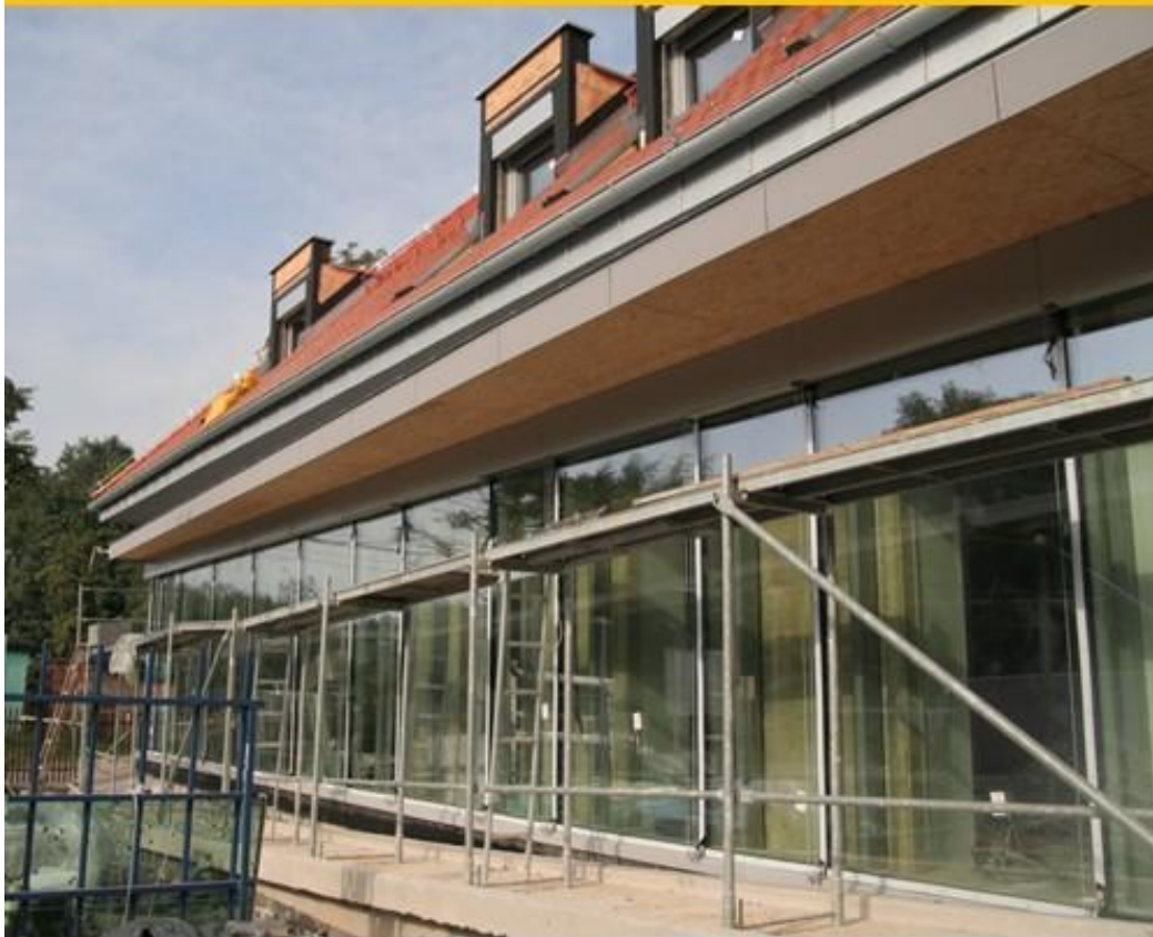
FASADA ALUMINIOWA SZYBY 0,4 W/m 2 k
