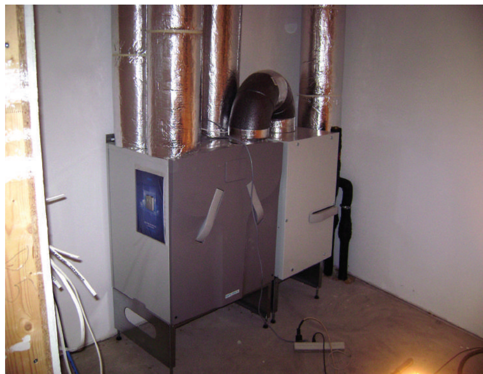
► Rys. 3. Centrala wentylacyjna w obiekcie referencyjnym znajdującym się pod Poznaniem.
