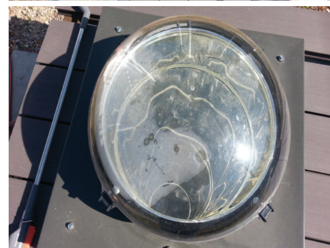
► Świetliki zamontowane na dachu Centrum Demonstracyjne Odnowialnych Źródeł Energii
