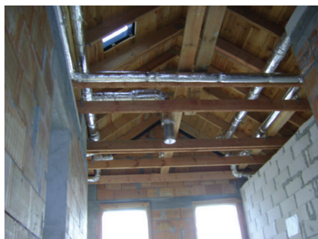
► Rys. 1. Instalacja wykonana w technologii kanałów sztywnych.
