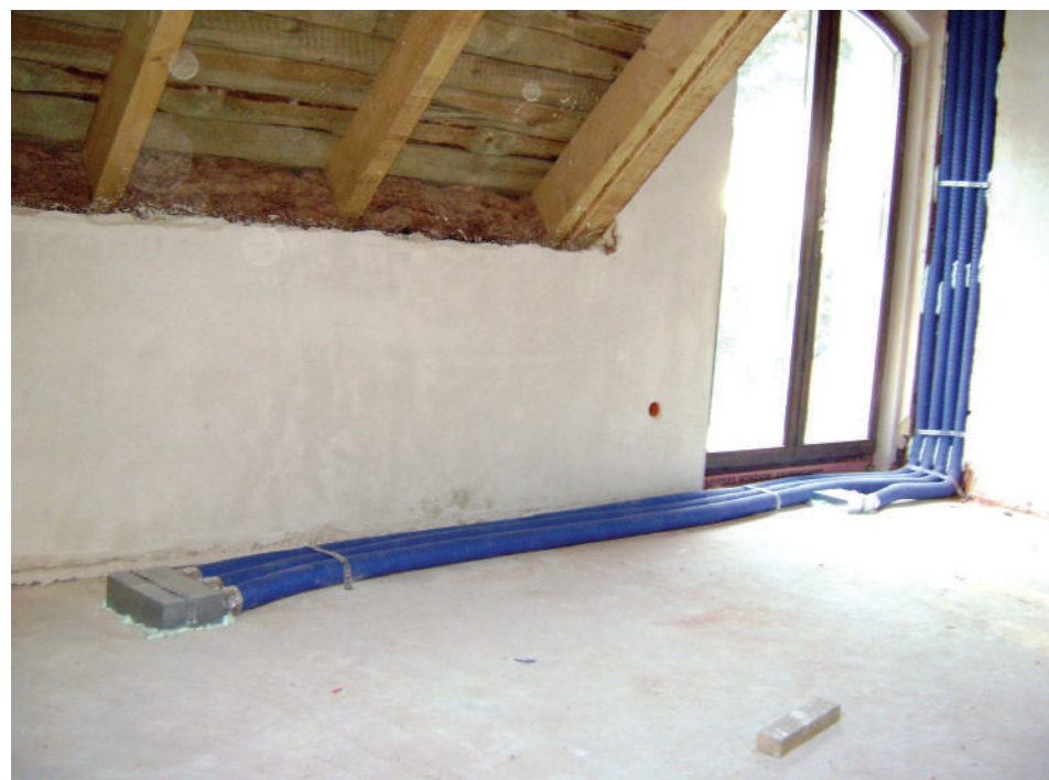
► Rys. 4. Instalacja wykonana w technologii kanałów elastycznych
