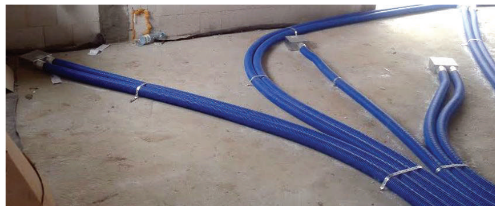
► Rys. 2. Instalacja wykonana w technologii kanałów elastycznych
