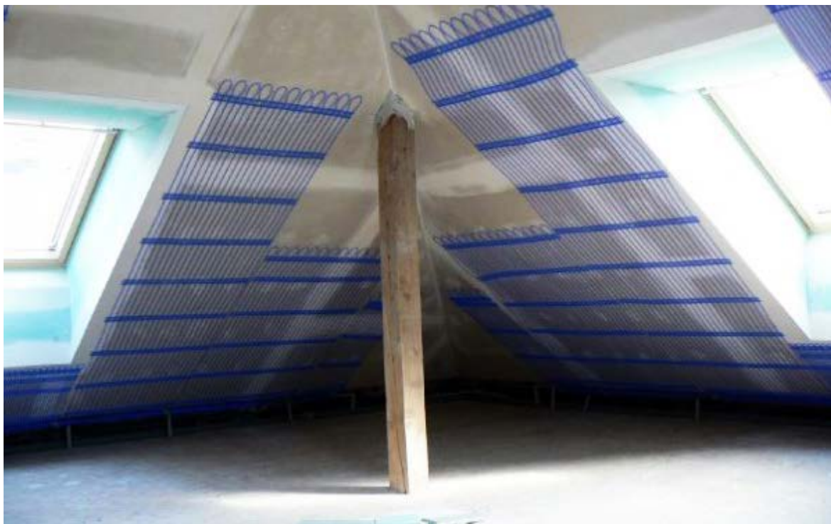
► Rozłożenie systemu grzewczego na skosach poddasza.
