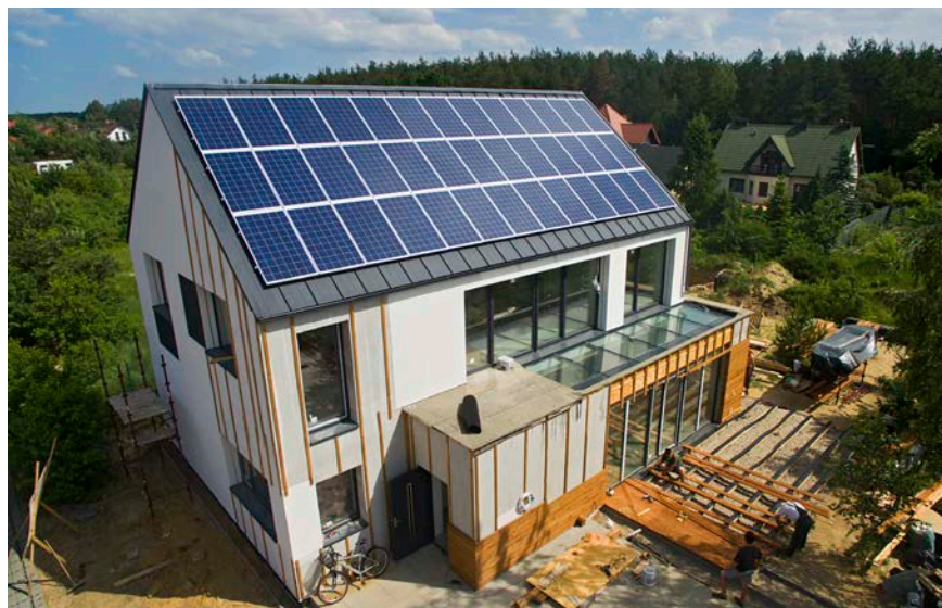
Fot. Budynek zeroenergetyczny pod Warszawą w trakcie prac wykończeniowych, źródło: Bison Energy
