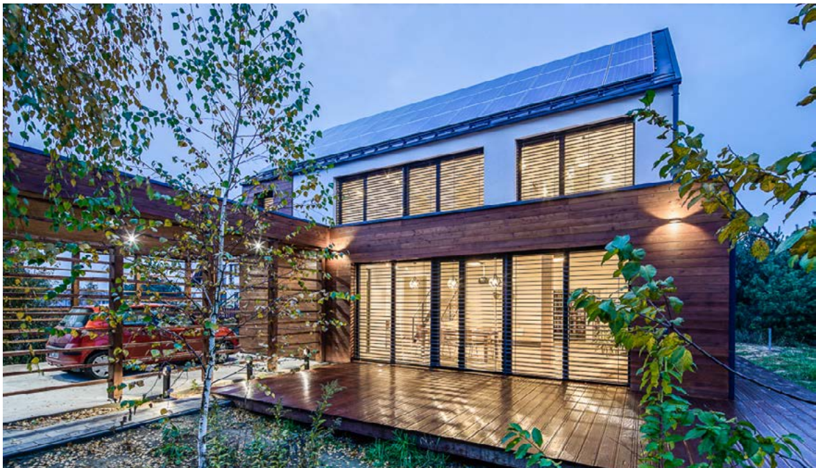
► Dom w Legionowie - elewacja południowa
