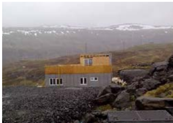
► Budowa domu wielorodzinnego na Wyspach Owczych
