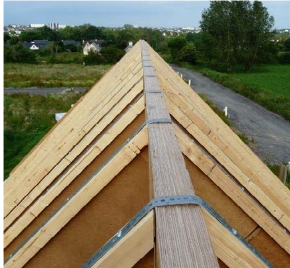
► Dach z belek dwu-teowych STEICO
