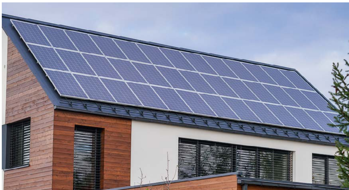
► Panele fotowoltaiczne na dachu
