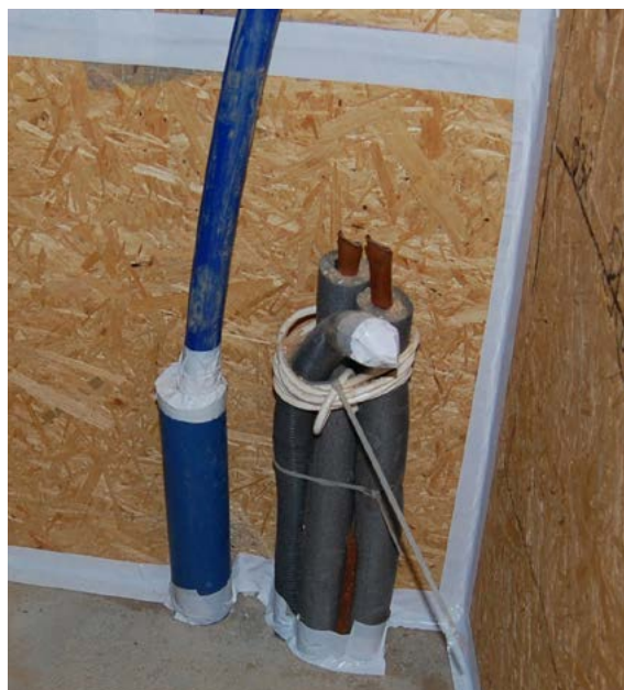
► Prawidłowe wykonanie przejść instalacji przez posadzkę
