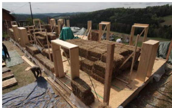
► Fotografia z budowy
