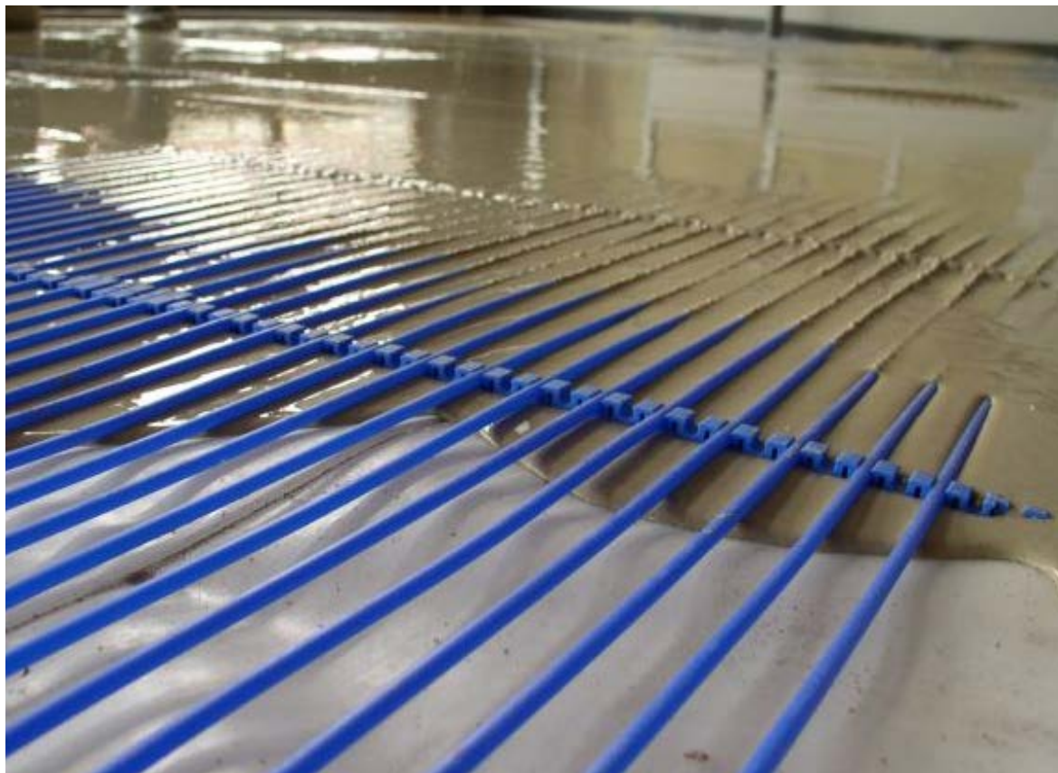
► Ogrzewanie matami kapilarnymi w warstwie wylewki
